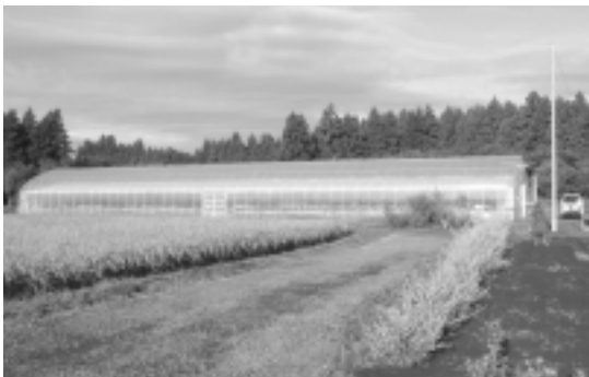
農場入口からみたパイプハウス全景
